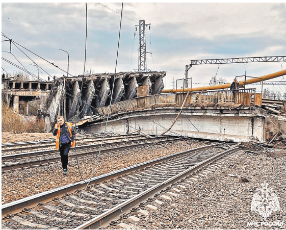
Обломки моста повредили газопровод. К работе срочно подключили аварийные бригады газовиков.
