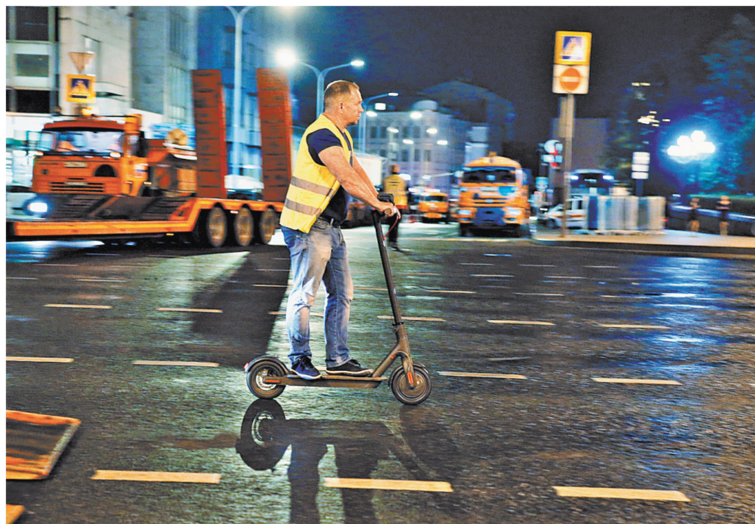
Во время ремонта не простаивала ни одна единица техники.
